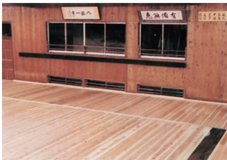
移設された床板
