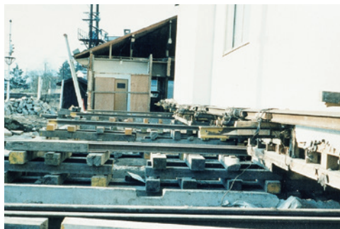
第3次道場移設拡張工事（新幹線開通のため）曳家工事
